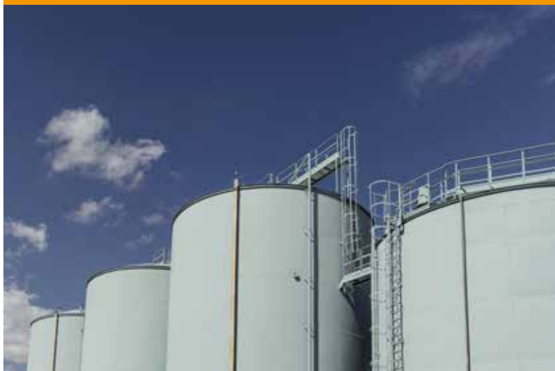
Alcuni dei grandi silos di stoccaggio delle materie prime presenti nello stabilimento di Faenza
